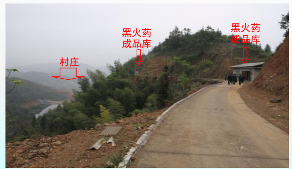
黑火药仓库面向村庄方向无防护
