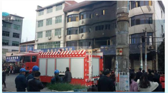
浙江永康“2·19”事故现场：“下店上宅”
