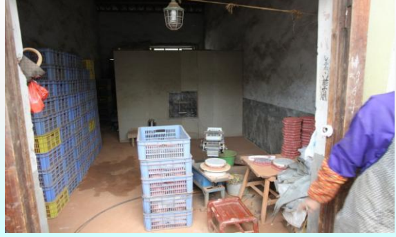
机械插引工房未设隔离防火墙
