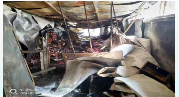
山东枣庄“2·19”事故现场
