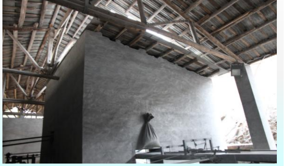
机械装药工房抗爆间不符合标准规定
