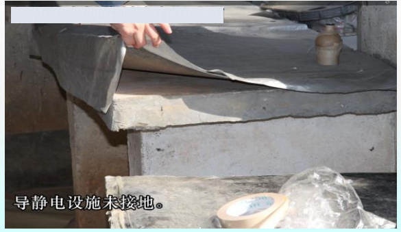
作业台面导静电设施未接地
